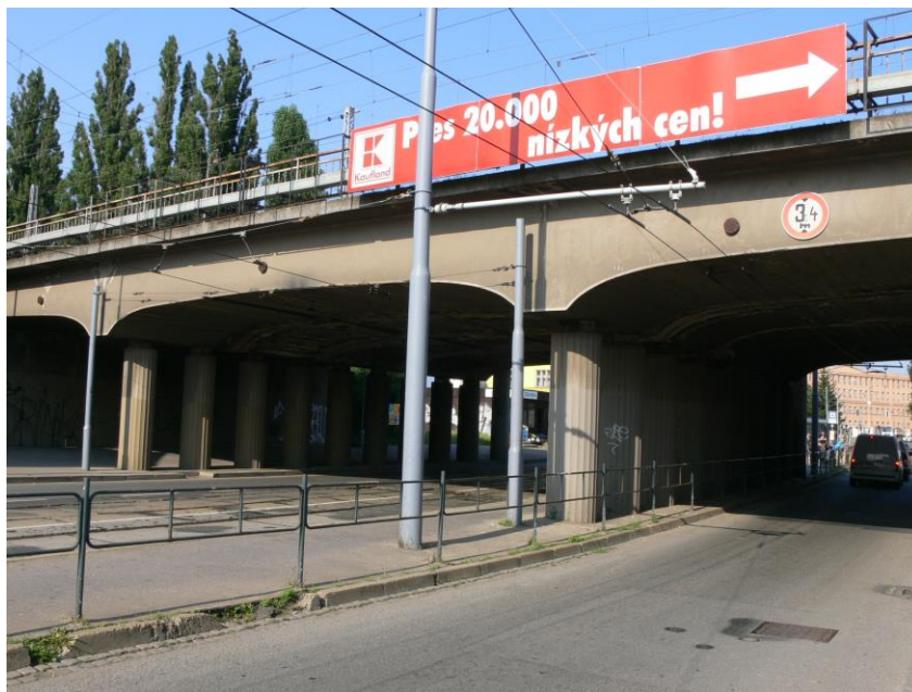
Obr. 6 Stávající most přes ul. Bubeníčková v žst. Brno Židenice
